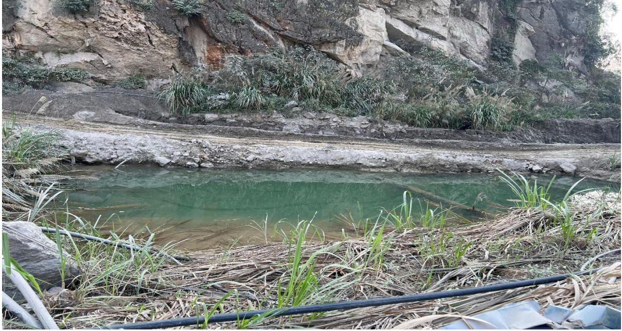
Hình 3. 5. Bể lắng 3 ngăn tuần hoàn nước thải rửa cát
